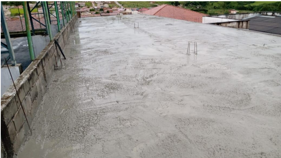
4 Laje Concretada
