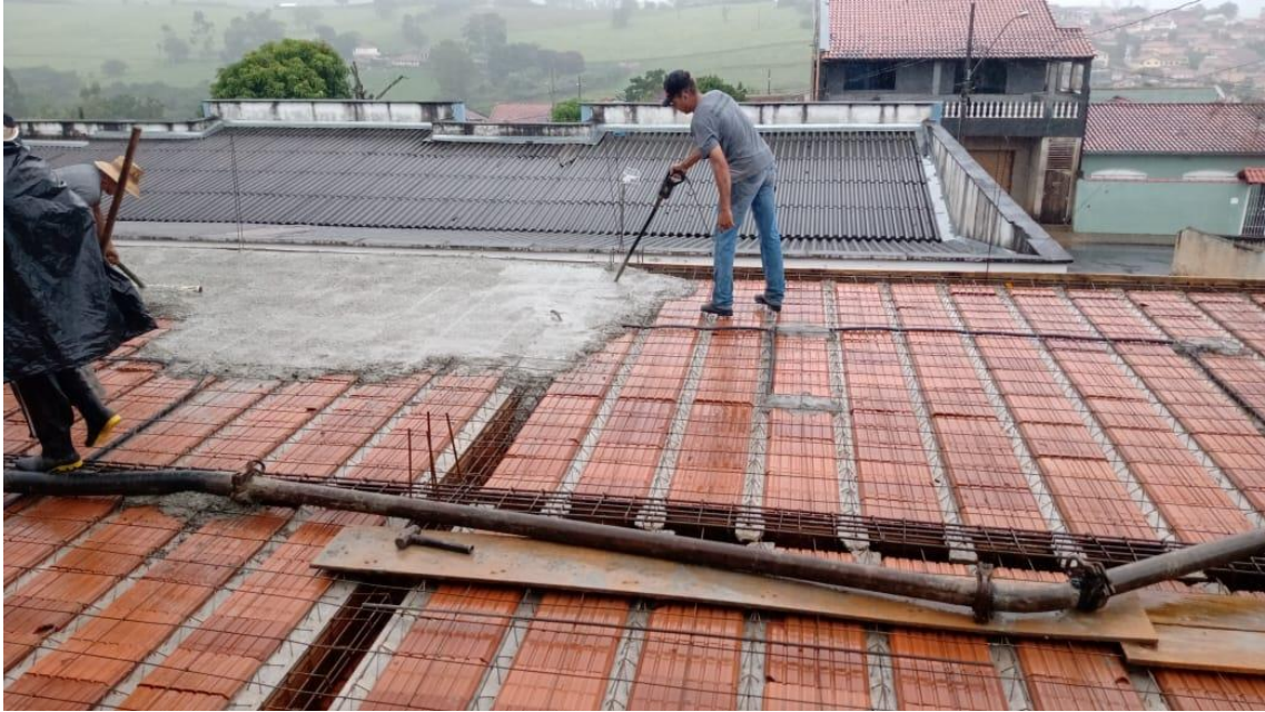
5 Concretagem de Laje
