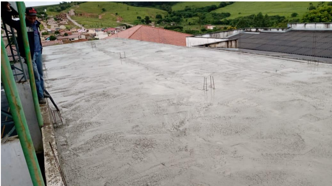
2 Concretagem de Laje
