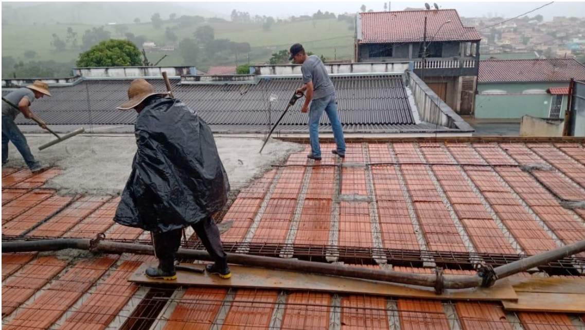
1 Concretagem de Laje
